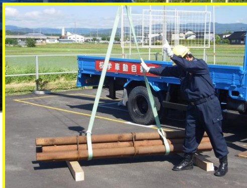
玉掛け作業の風景 ←
